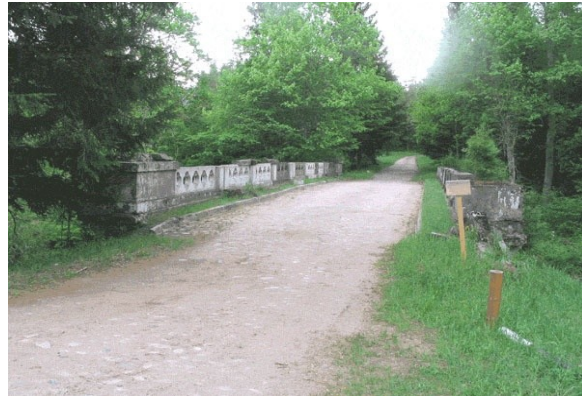
( Abb.5 Die Hirschbrücke bei unserem Besuch 2011 )
