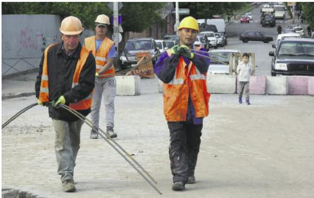
Hinter dem Zeitplan: Bauarbeiten an der Brücke auf der Aweider Allee
