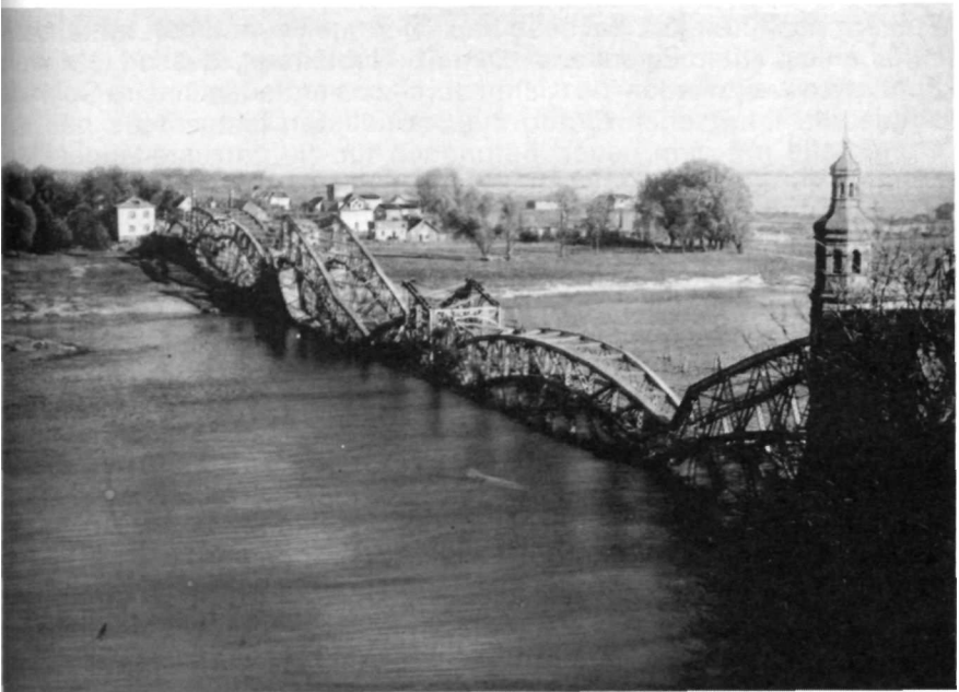
Die Königin-Luise-Brücke wurde am 22. Oktober 1944 von deutschen Truppen während des Rückzuges gesprengt.
