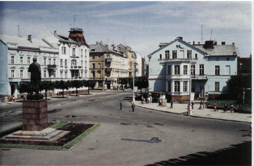
Am Hohen Tor (heute Leninplatz) erinnern noch viele - inzwischen restaurierte - Gebäude an das alte Tilsit. Rechts die Einmündung der Clausiusstraße (Leninstraße). Im Hintergrund der Beginn der Hohen Straße. Fotos: Siegfried Maruhn
