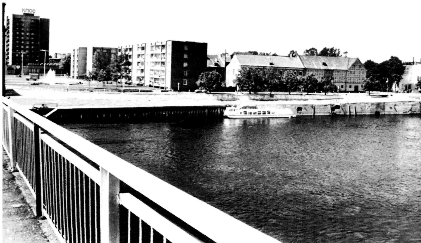
Das heutige Stadtpanorama von Tilsit (Sowjetsk), von der Memelbrücke aus gesehen. Links der Fletcherplatz mit neuer Bebauung. An das alte Tilsit erinnert das Fachwerkhaus, rechts im Bild, an der Memelstraße/Ecke Packhofstraße. Das Tragflächenboot am Memelufer verkehrt regelmäßig zwischen Tilsit und Kaunas (Kowno).
