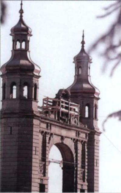
Die Hauben der beiden Portaltürme erhielten eine neue Kupfereindeckung, und die Sandsteinfassade wurde restauriert. Gearbeitet wird hier über der Einfahrt am Medaillon, in dem sich einst die Büste der Königin Luise und nach dem Krieg Hammer und Sichel befanden.
