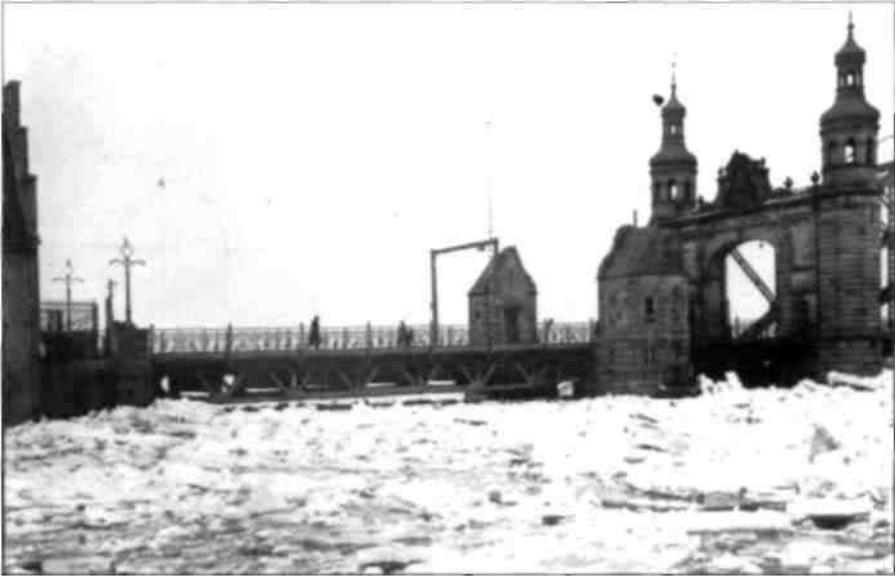
Eisschollen zerbersten an den Pfeilern der Luisenbrücke. Das Packeis hat fast die Unterkonstruktion der Brückenfahrbahn erreicht. *Foto: Wasserbauamt Tilsit*
